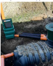
Szekrény védőcsővel összekötve, nyomócsövek
