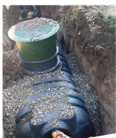
Rikutec 4000L tartály lehelyezése, sódertöltet
