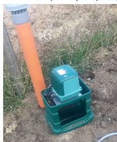
Elektromos vezeték, DUO kompresszor, huzatfej
