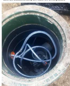
Csővek összekötése, diffúzorok elhelyezése
